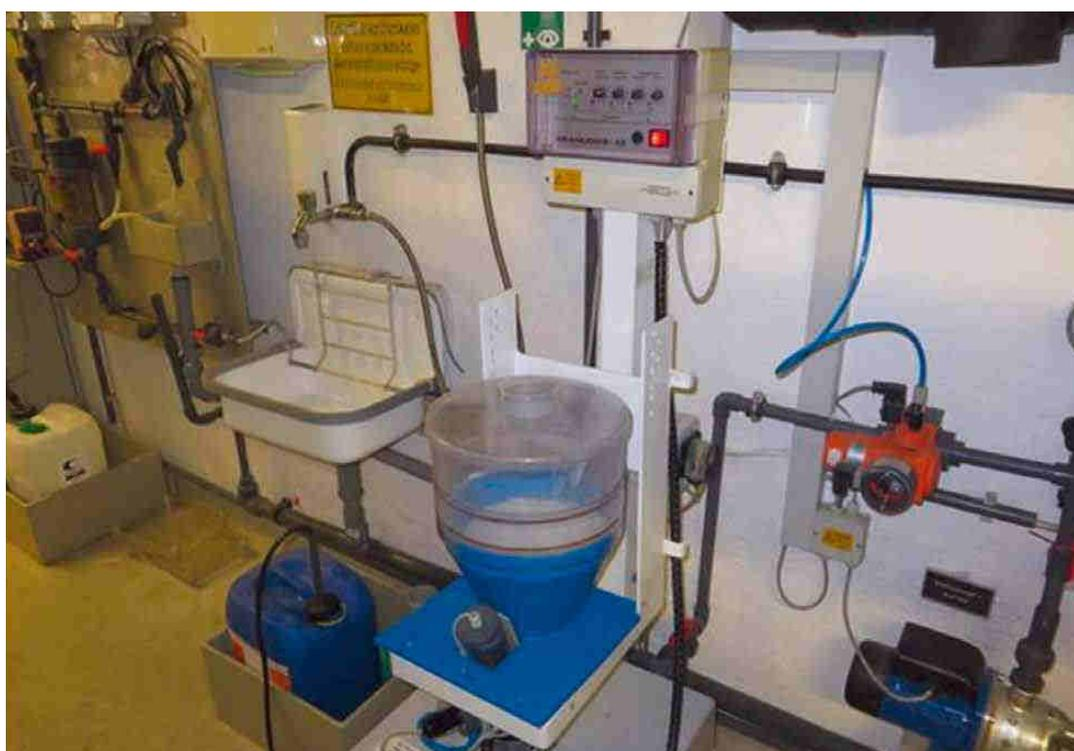
Chlorierungsanlage mit Chlorgranulat im Technikbereich eines Lehrschwimmbeckens
