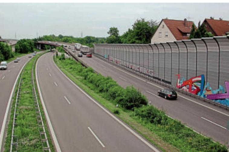
Die Lärmschutzwand in Zuffenhausen an der B 10/27 wurde um 2,5 m erhöht.
